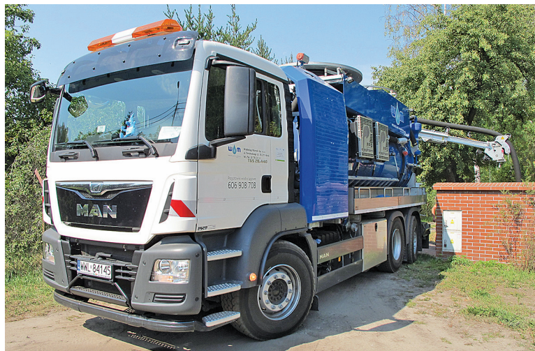
Czyszczenie pompowni P17 z wykorzystaniem samochodu ciśnieniowego.
