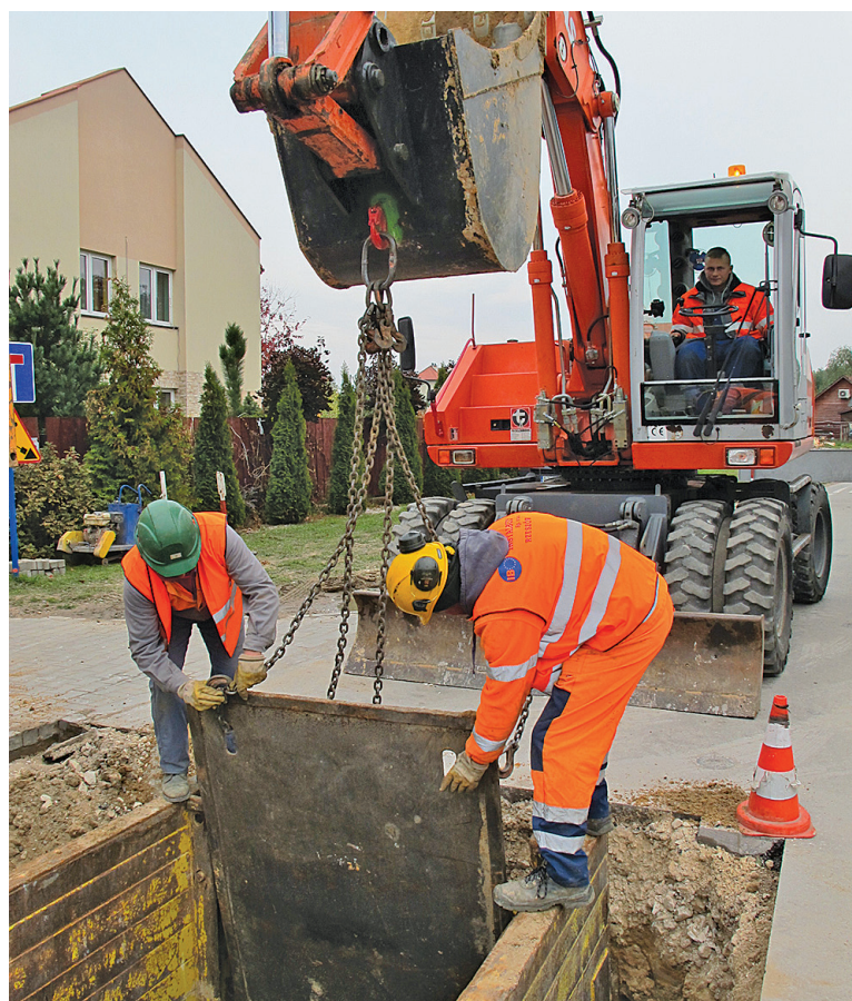
Szalowanie wykopu przed montażem studzienki w ul. Granicznej.
