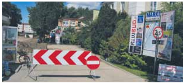
Roboty budowlano-montażowe przy Urzędzie Miasta Marki
